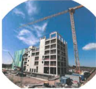
Construction usine d'Offstein : Fin Q1 2025
